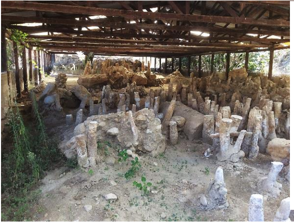
Links: de oude houten fundamenteën van de brug over de Strymon
